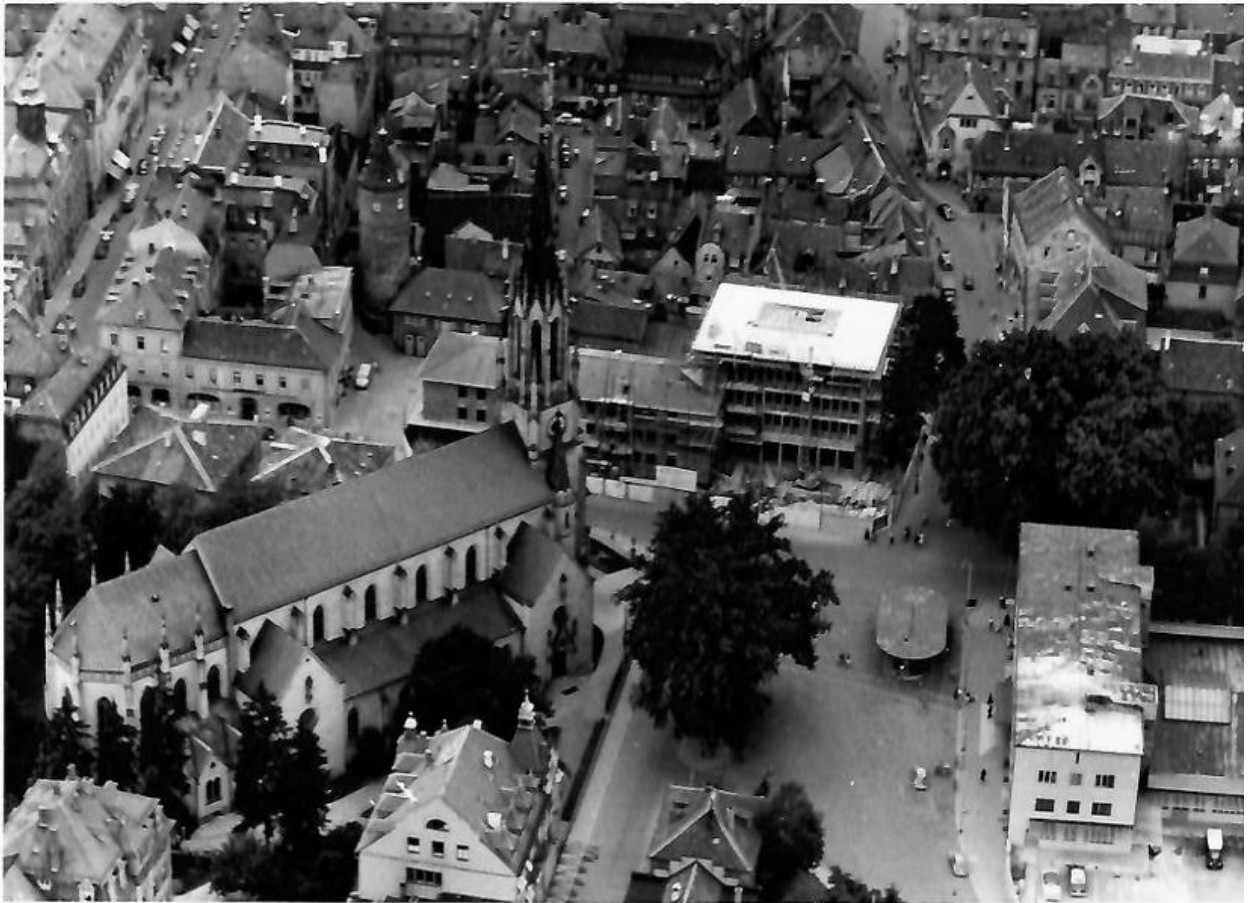
Blick auf die Bauarbeiten aus der Luft.
